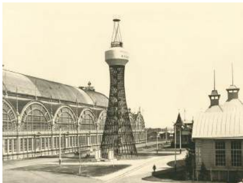
Гиперboloидная башня. Инженер В. Г. Шухов
