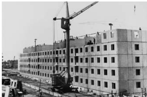
Строительство пятиэтажного жилого дома. Город Волжский
