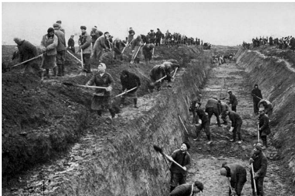
Строительство оборонительных сооружений под Москвой. Осень 1941 г.
