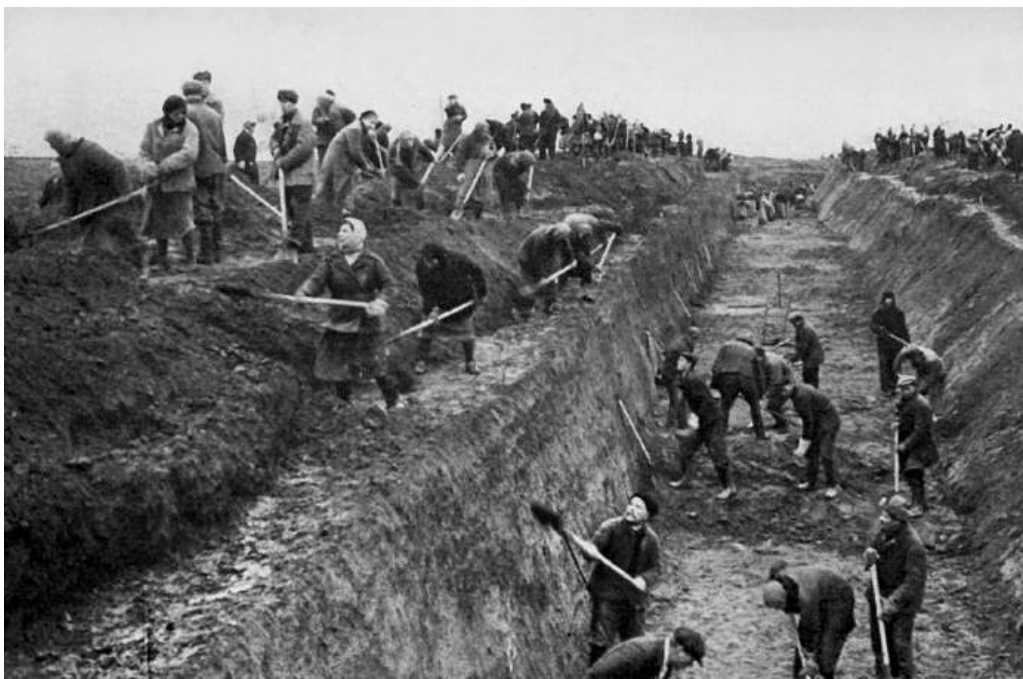
Строительство оборонительных сооружений под Москвой. Осень 1941 г.
